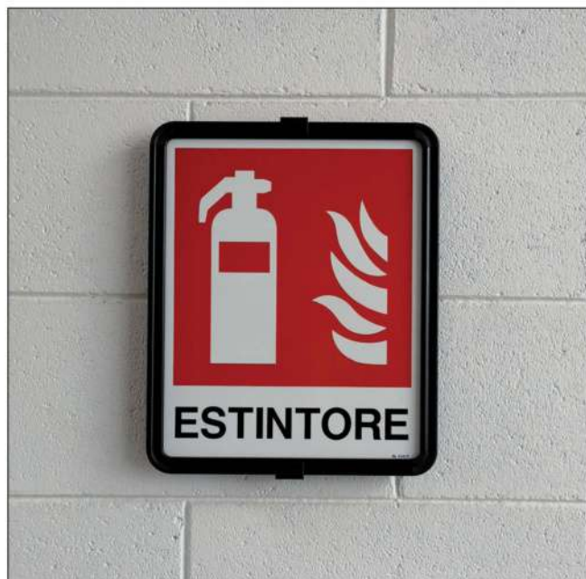
INSTALLAZIONE DI SEGNALI MONOFACCIALI
